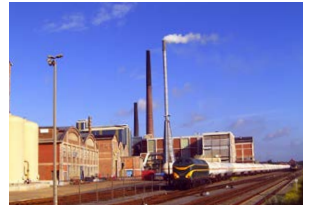
Afb. 5.35 Fosfaatverwerkende industrie bij Tessenderlo.
