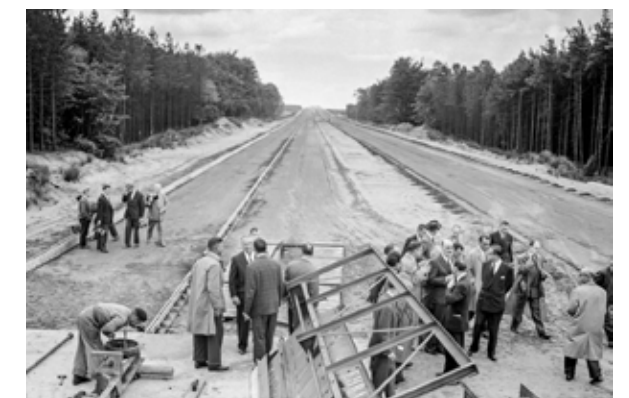
Afb. 5.33 De aanleg van de Koning Boudewijnsnelweg (1958-62).
