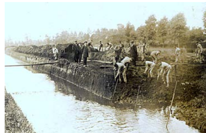
Afb. 5.5 Turf steken aan de Molderdijk (Mol).
