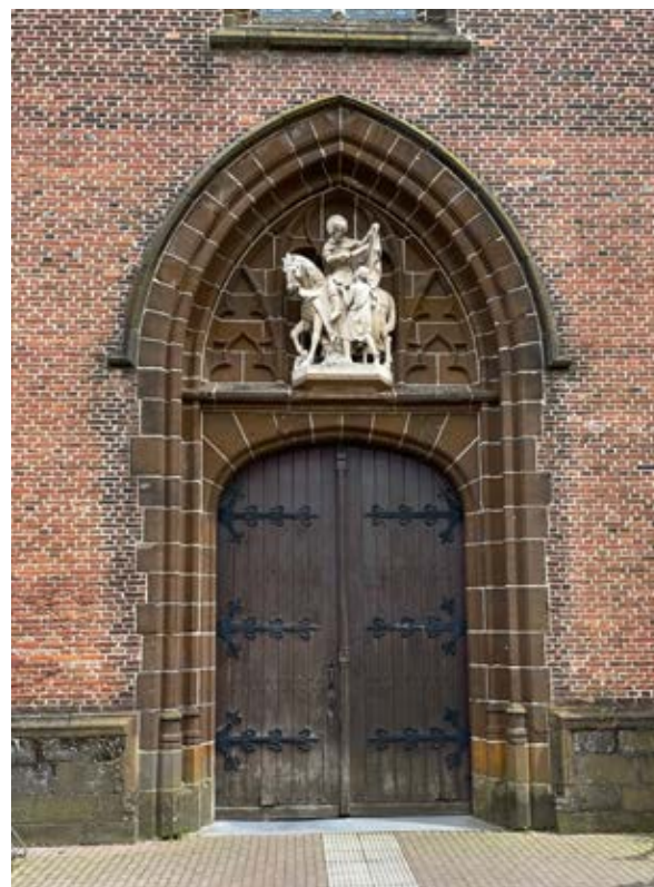
Afb. 4.43 In de Sint Lambertuskerk te Westerlo is ijzerzandsteen verwerkt. Ijzerzandsteen is veel gladder van structuur dan ijzeroer en ook iets lichter van kleur.
