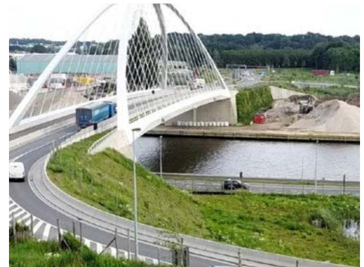
afb. 7.30. Verbinden natuurgebieden door verminderen ecologische barrières zoals kanalen en (spoor)wegen (ecologische ontsnippering). Voorbeeld ecostrook Hoogmolenbrug Albertkanaal.
