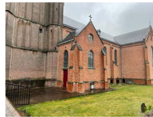
Afb. 4.45 De Sint Lambertuskerk te Bel is vervaardigd van verschillende typen (lokaal) vervaardigde bakstenen, elk met een eigen kleur.
